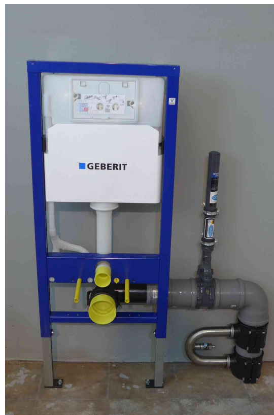
Einbaubeispiel: Vorwandmontage der Toilette
